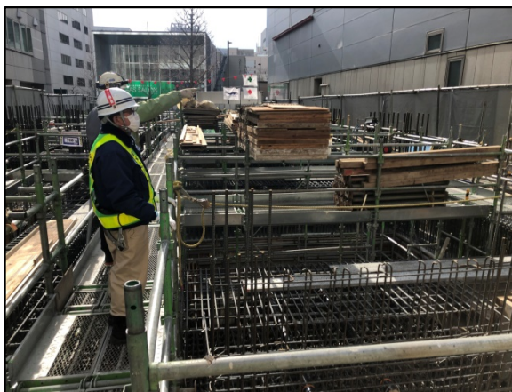
青葉区本町現場
